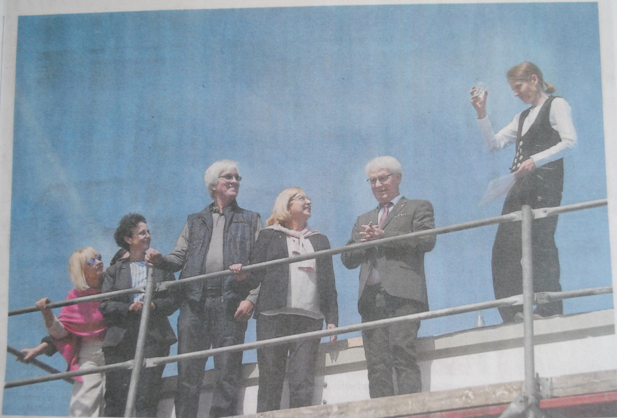
Die neue Mensa der Schule am Adelwald soll Ende des Jahres fertiggestellt werden. Gestern wurde Richtfest gefeiert.
